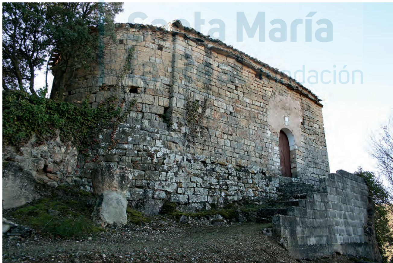
Vista desde el lado norte
