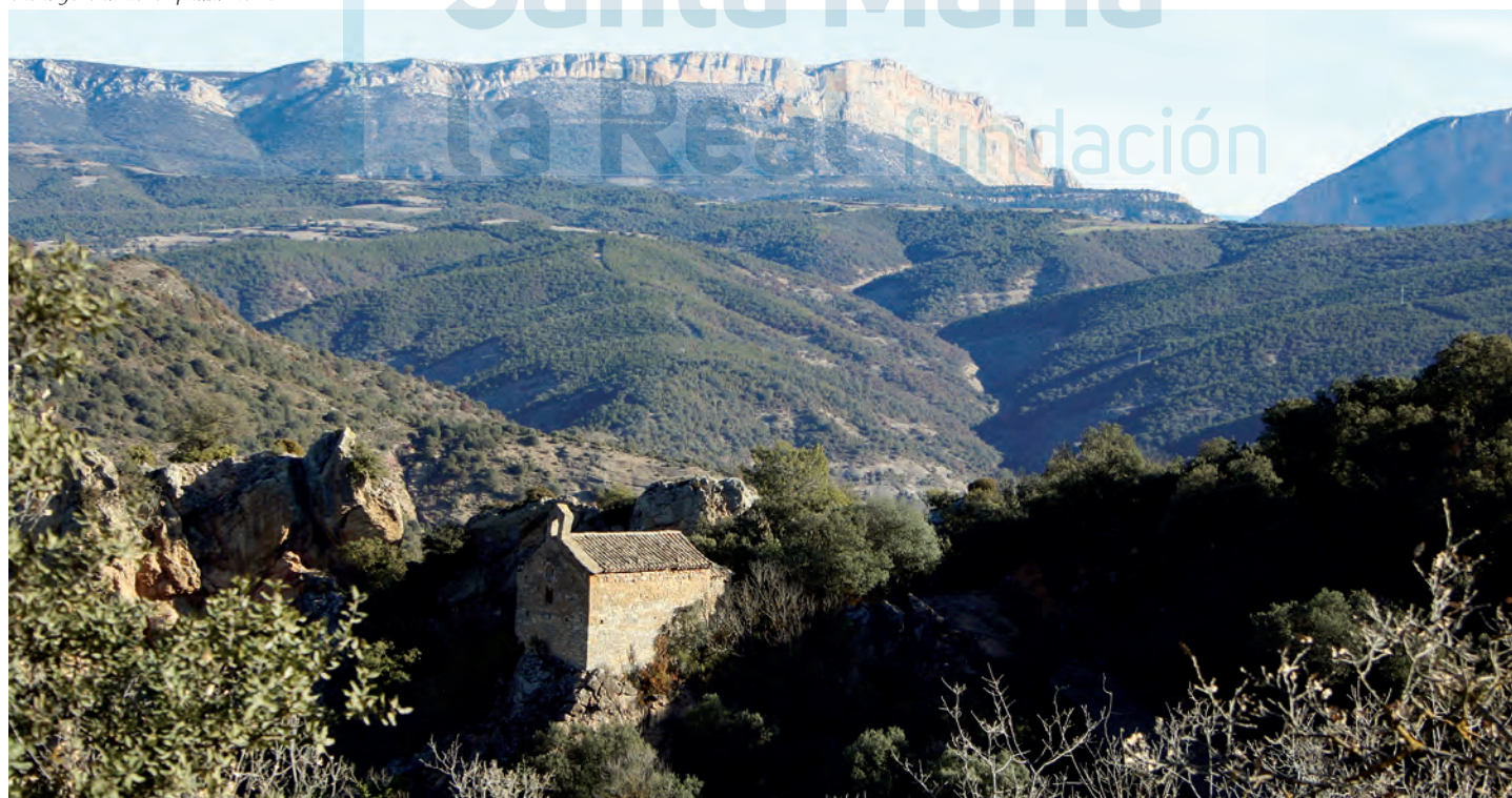
Vista general del emplazamiento
