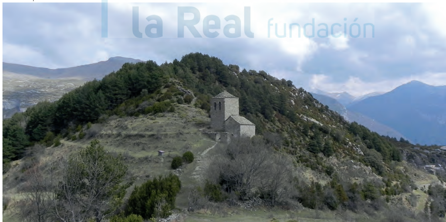
Vista del emplazamiento
