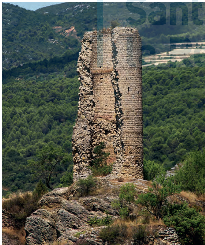
Vista general de la torre
