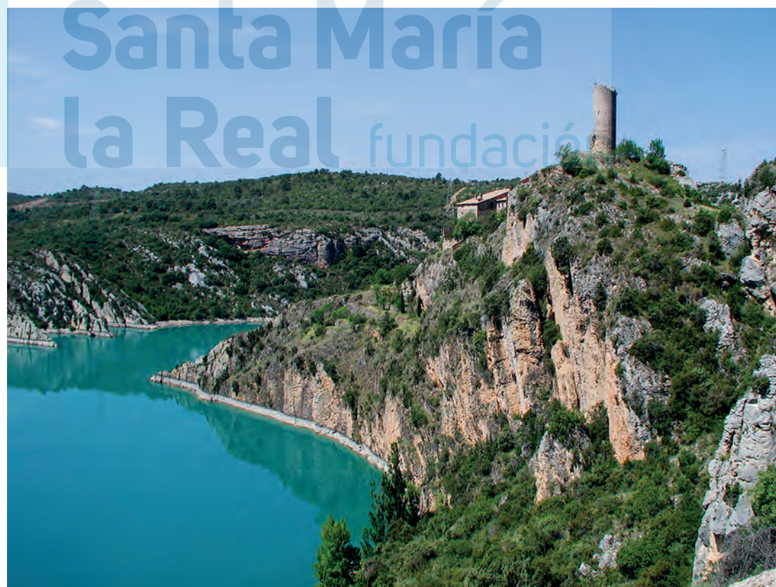
Vista general del emplazamiento de la torre
