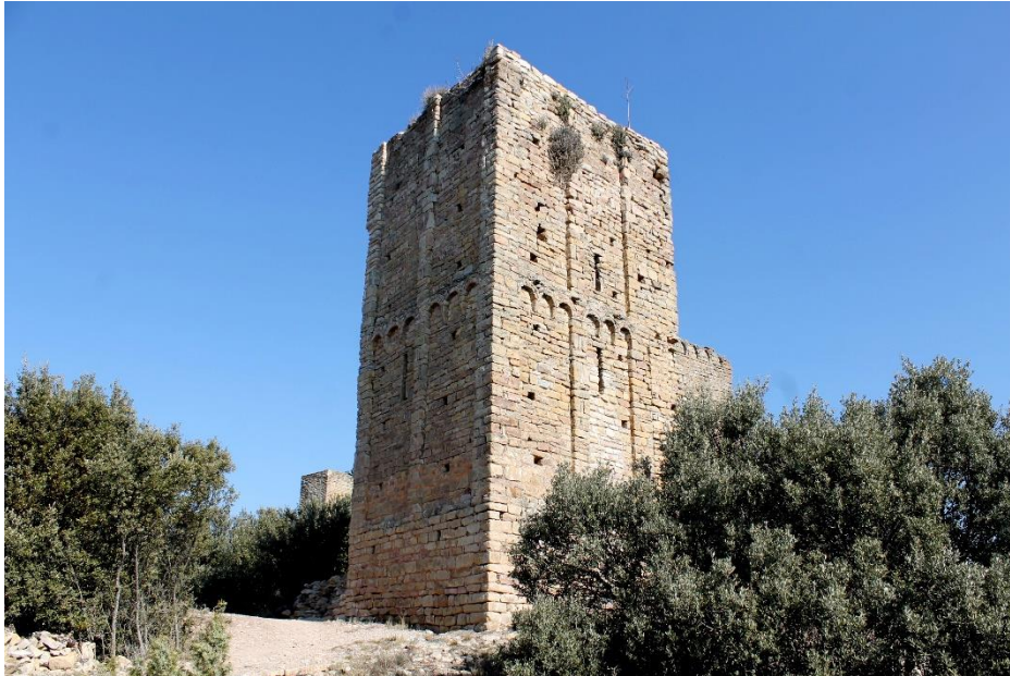
Vista exterior de la torre suroeste
