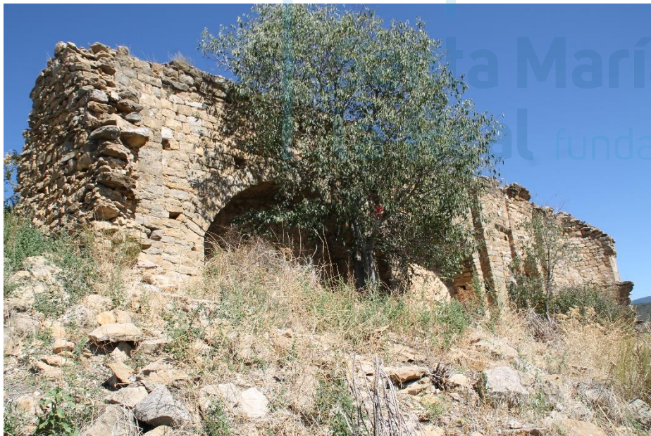
Vista interior de los restos del muro norte
