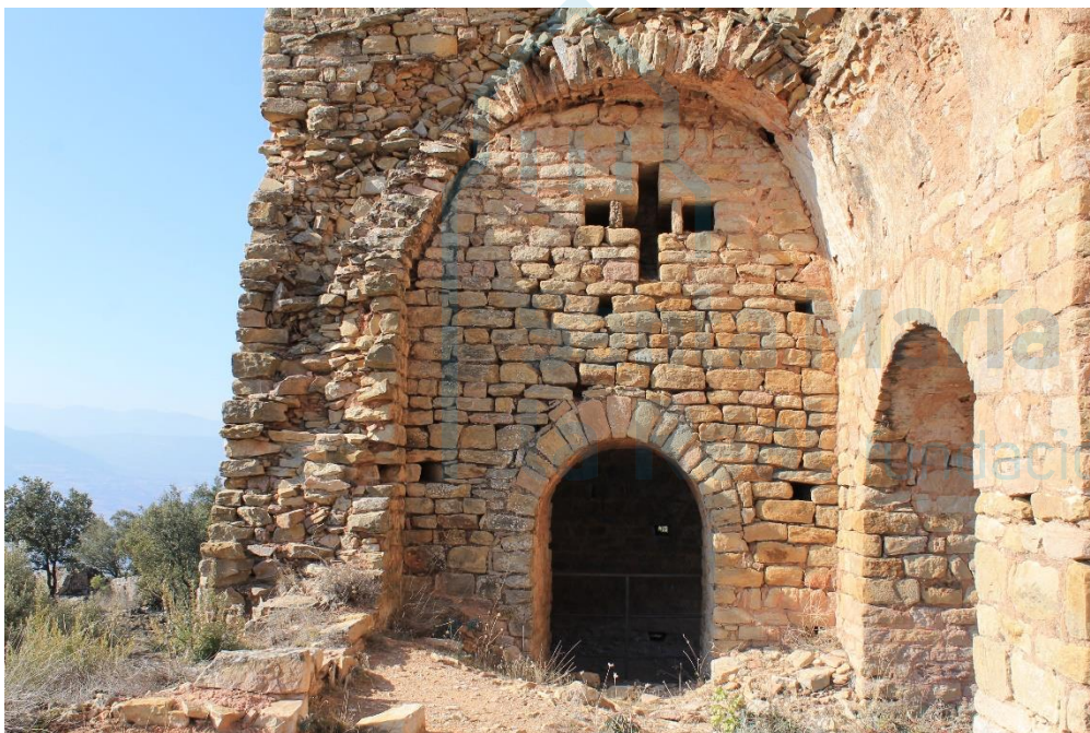
Puerta de acceso a la torre
