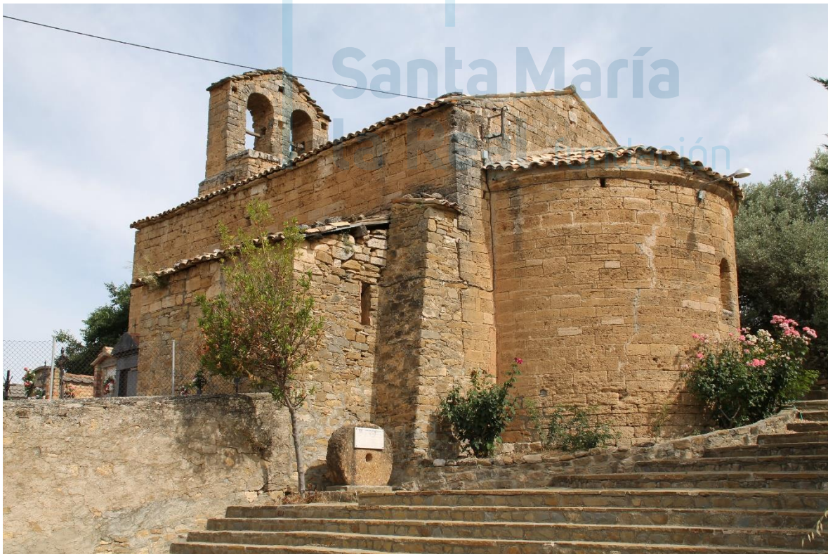
Vista general exterior desde el sureste
