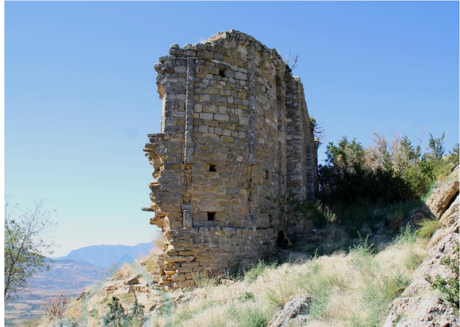
Vista exterior de los restos del ábside
