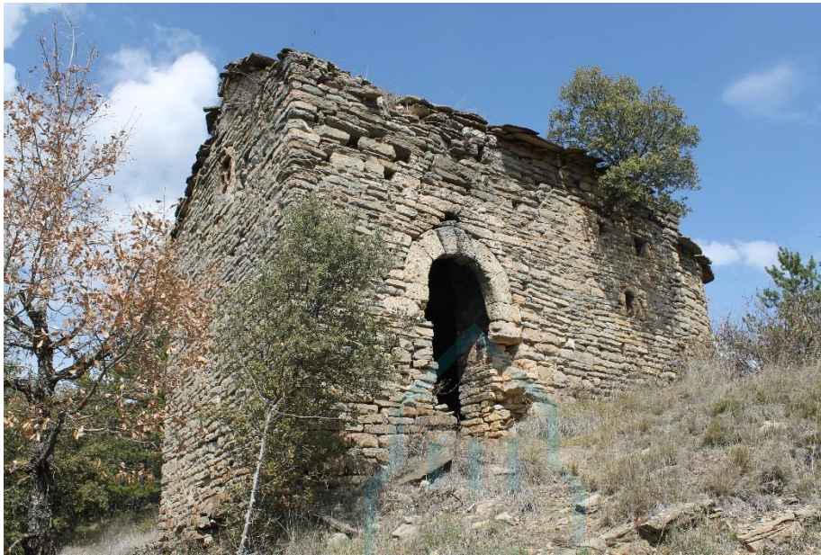
Vista exterior desde el suroeste
