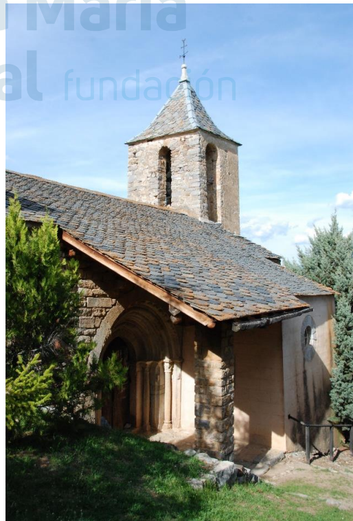
Vista general desde el lado sur
