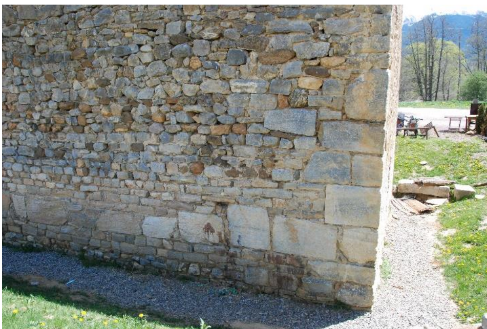
Detalle de paramento en el muro norte
