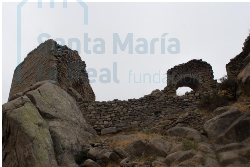
Restos de la torre y muralla
