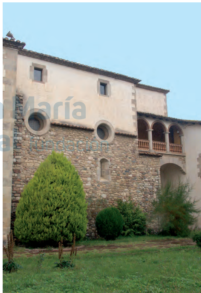
Restos en el muro sur
