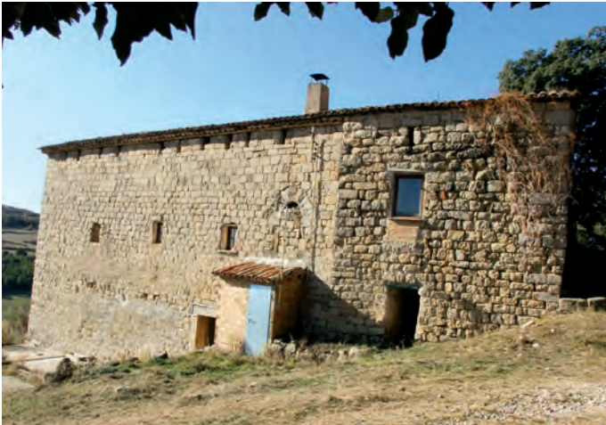
Vista general del estado actual del edificio
