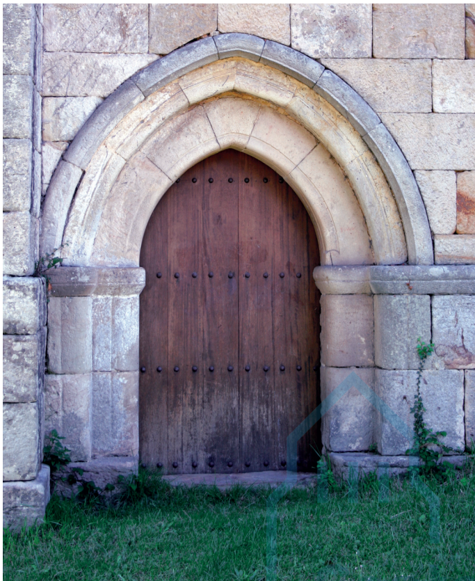
Puerta del muro norte de la iglesia
