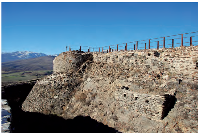
Torre circular y base de torre cuadrada
