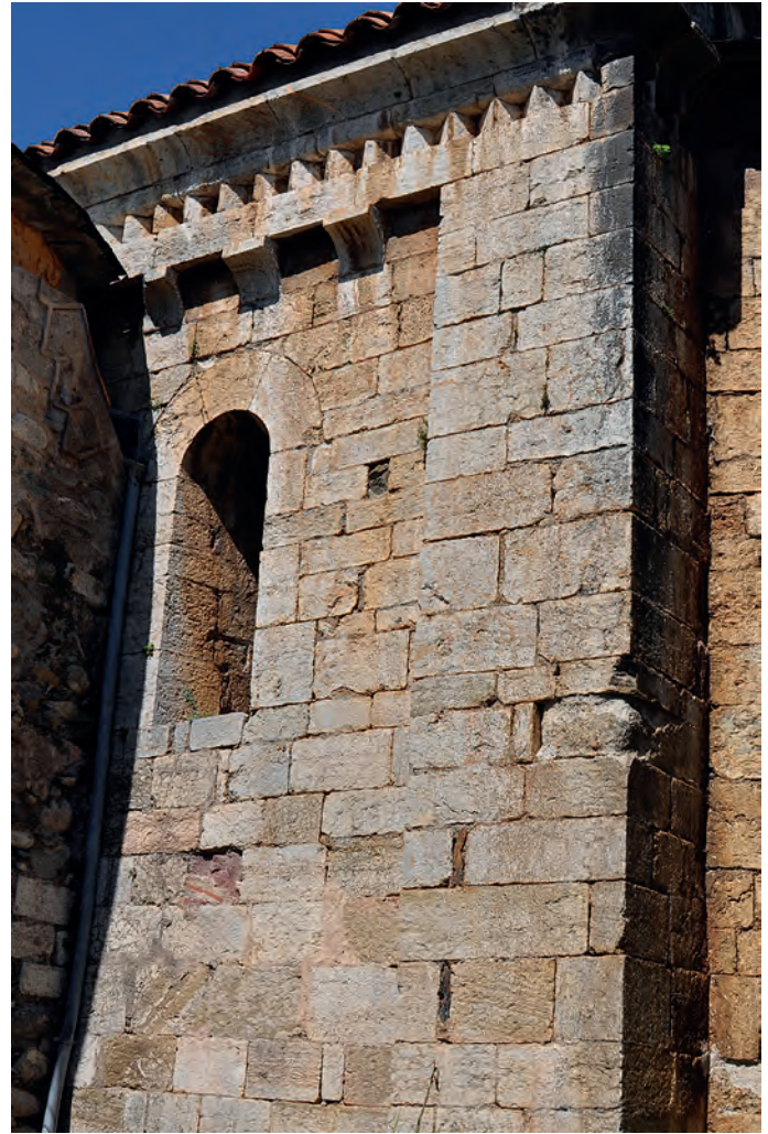
Detalle de la fachada sur
