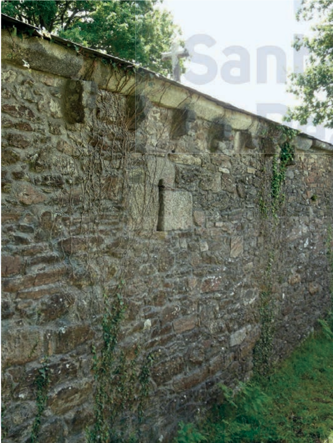
Restos de canecillos y ventana saetera en el lienzo norte
