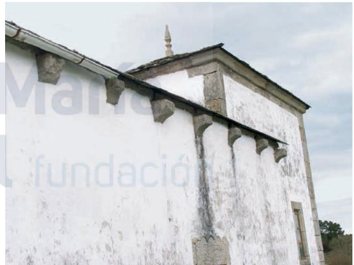
Alero sur de la nave
