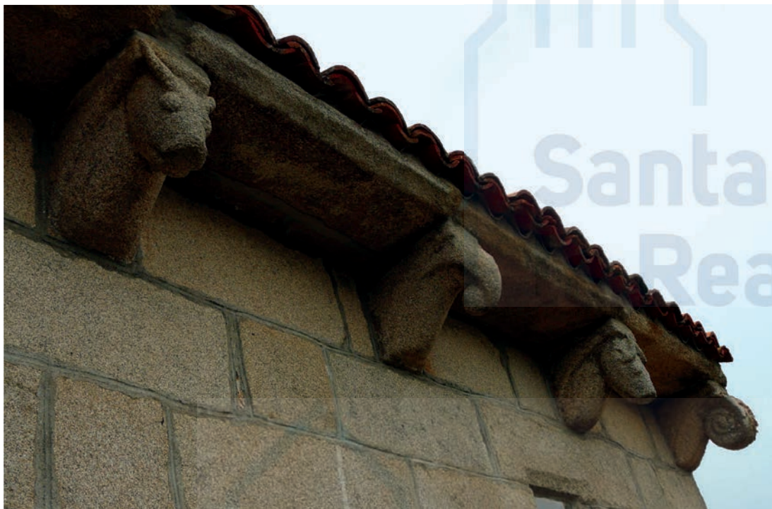
Capiteles del alero sur del ábside
