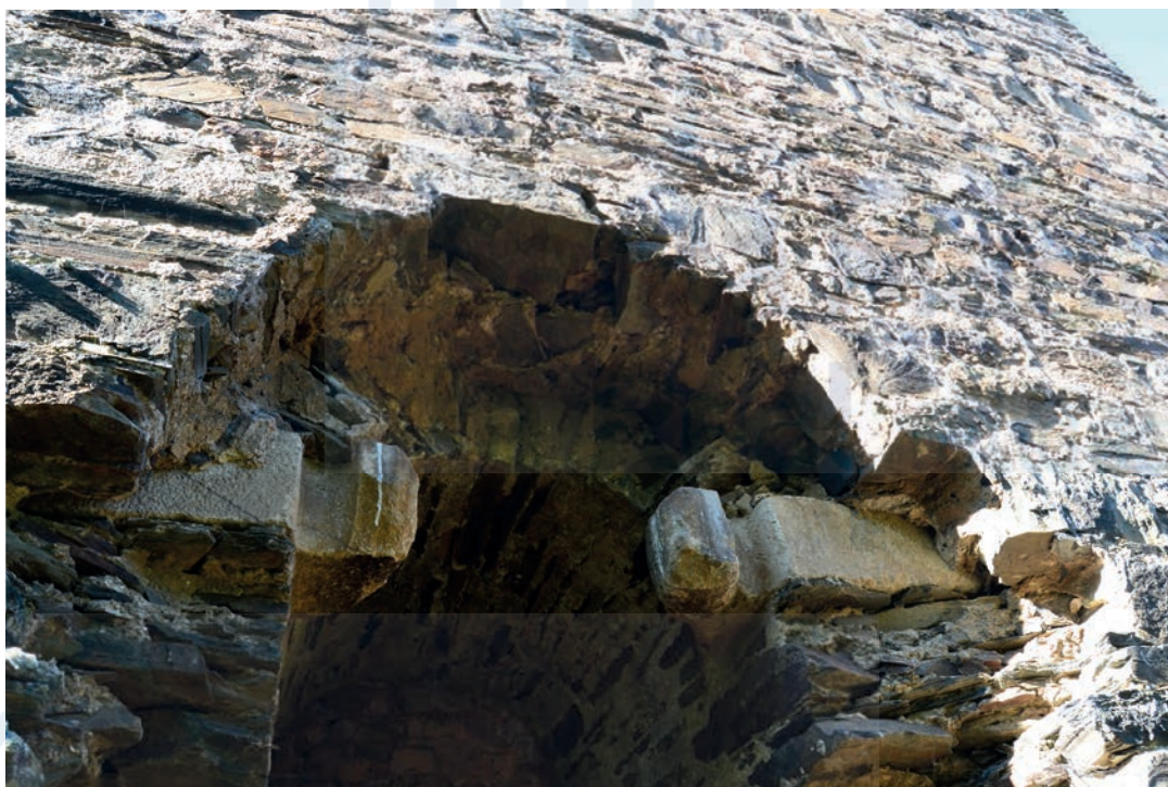
Puerta de acceso, detalle
