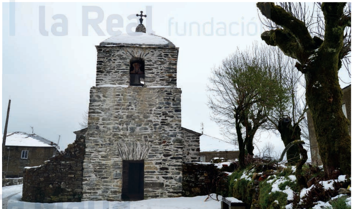
Vista general con la torre-pórtico
