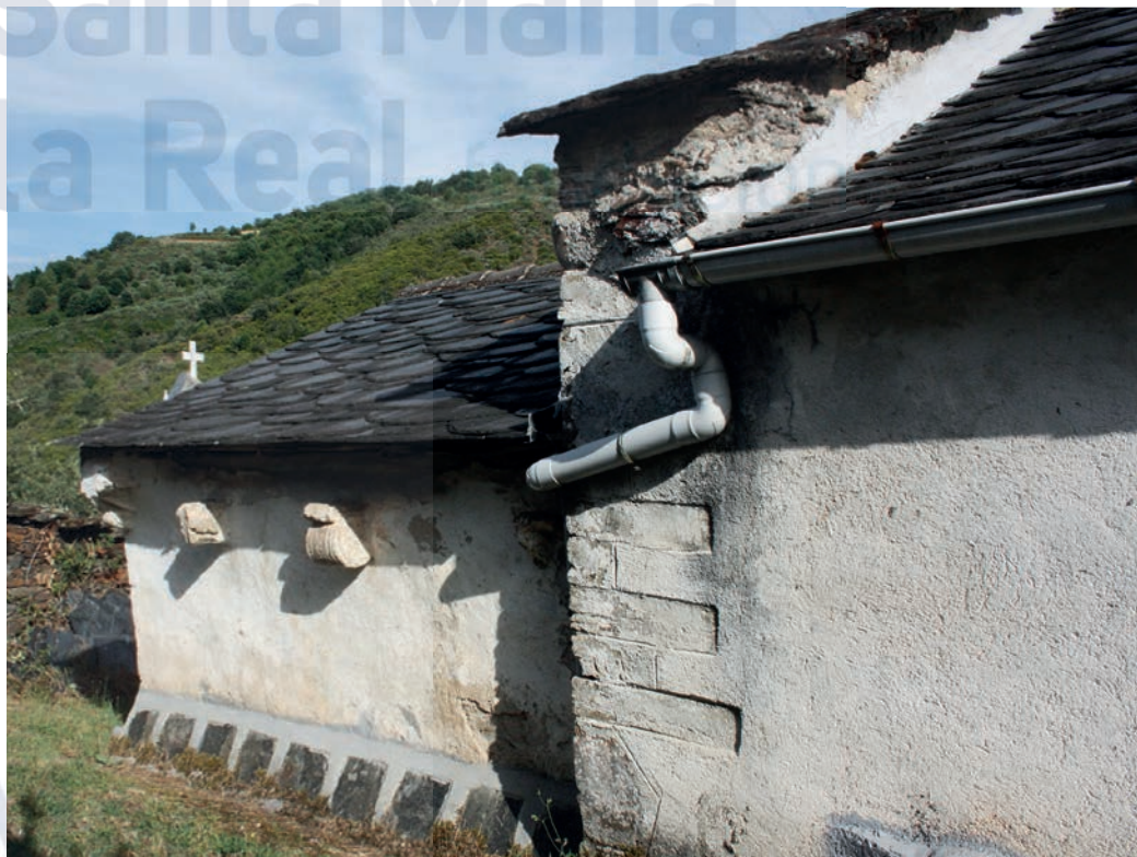
Canecillos del muro norte de la cabecera
