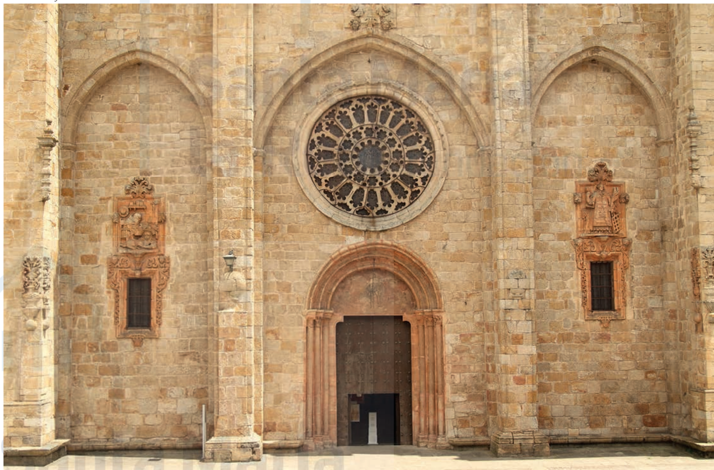
Detalle de la fachada oeste
