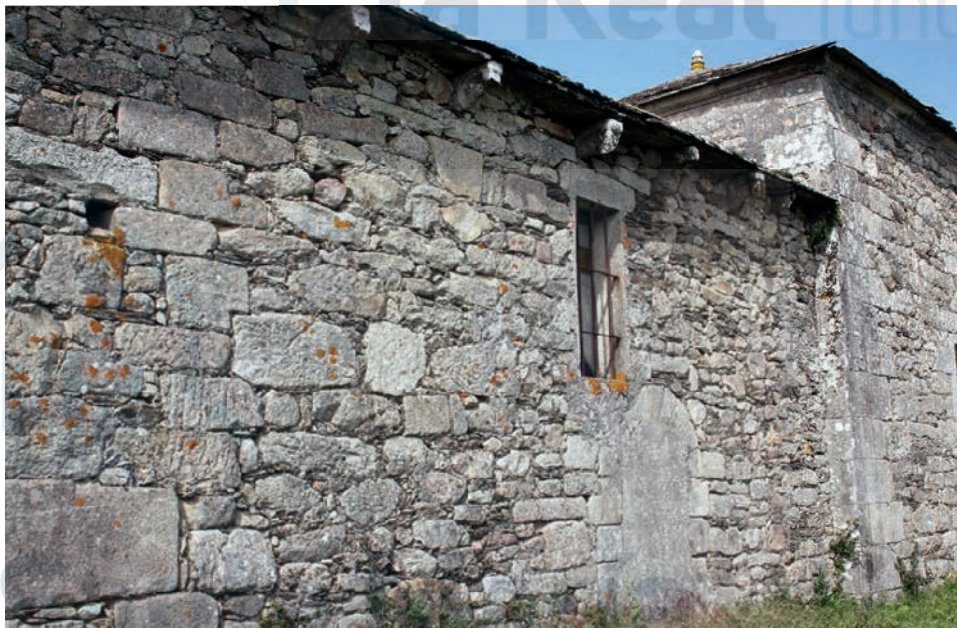
Muro sur de la nave
