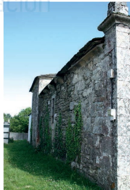
Muro norte de la nave
