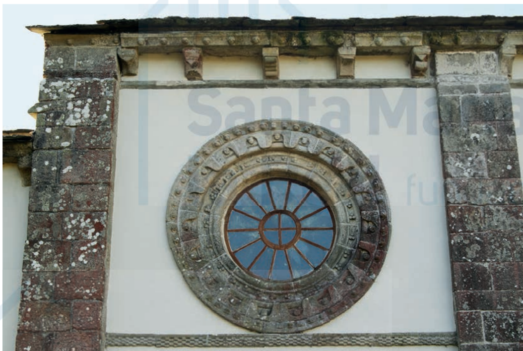
Rosetón y canecillos del muro norte
