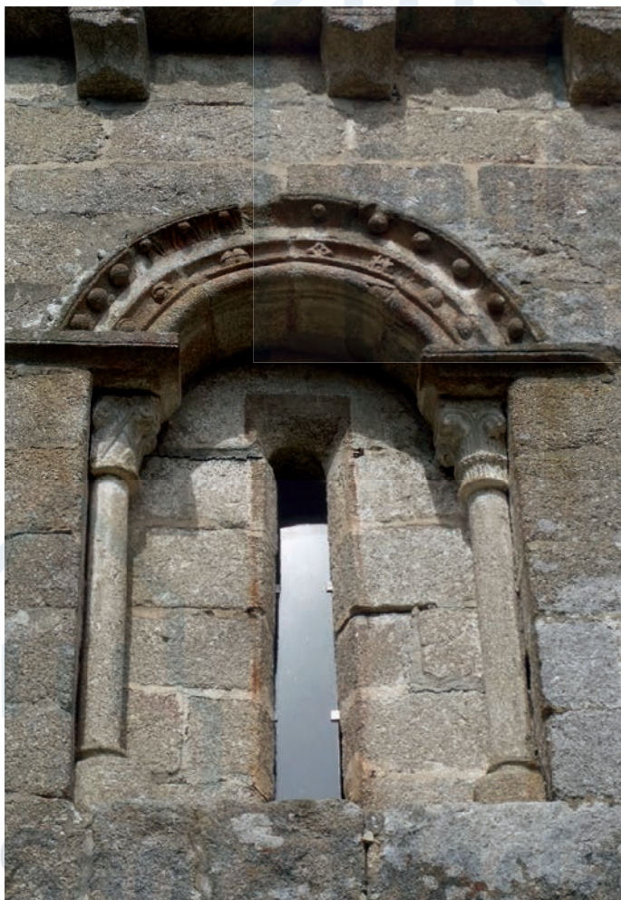
Ventana del muro sur
