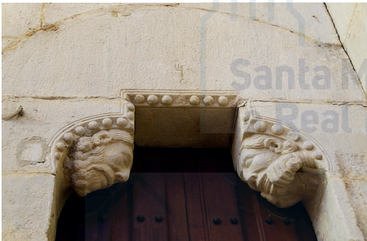
Acceso a la escalera del ángulo noroeste
