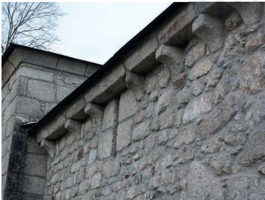
Detalle del alero norte de la nave
