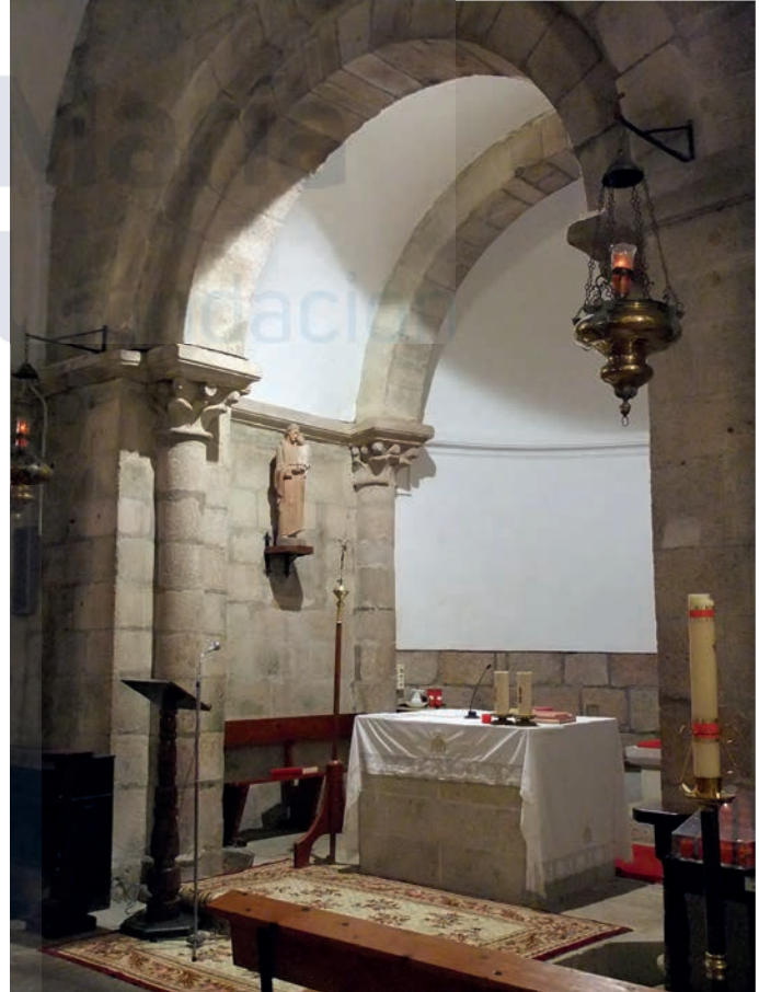
Interior del ábside
