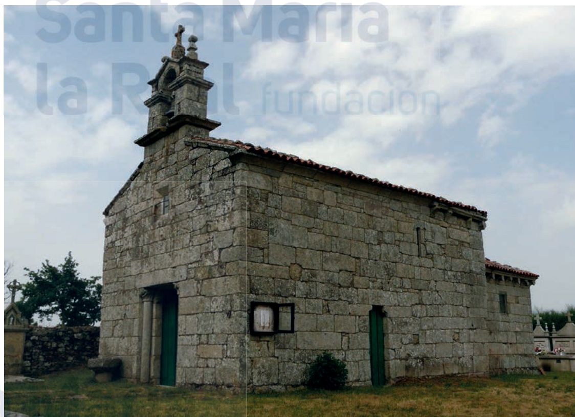
Vista desde el lado suroeste
