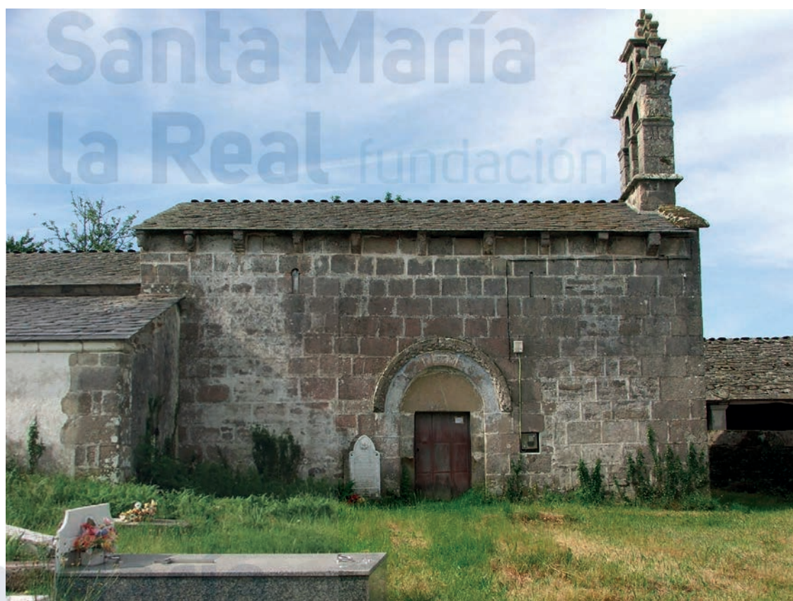
Muro norte de la nave
