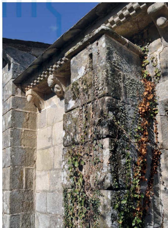
Alero y muro sur del ábside
