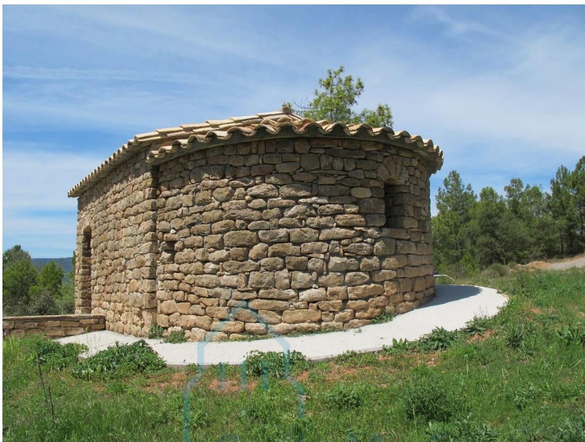
Vista general después de la restauración
