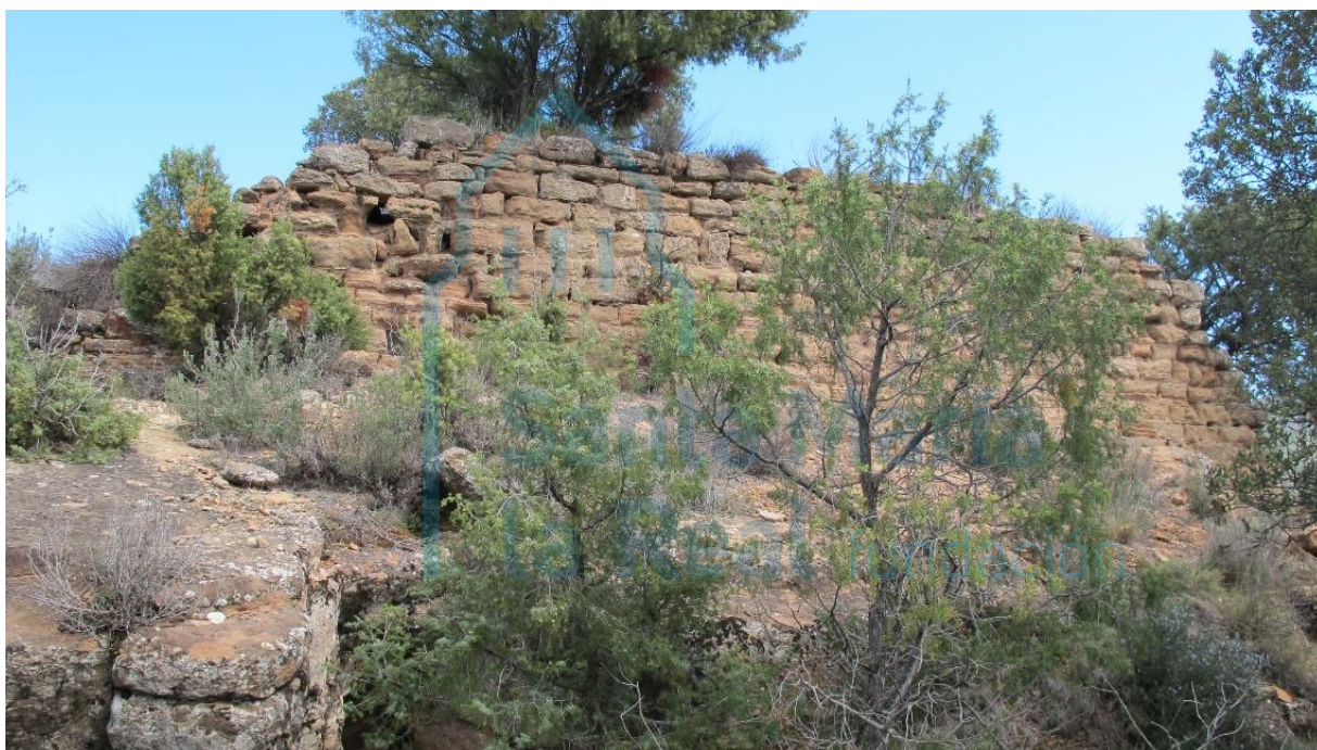
Vista exterior del muro sur
