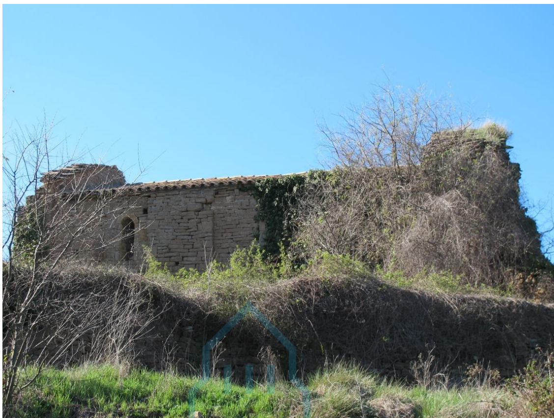
Vista del exterior muro sur
