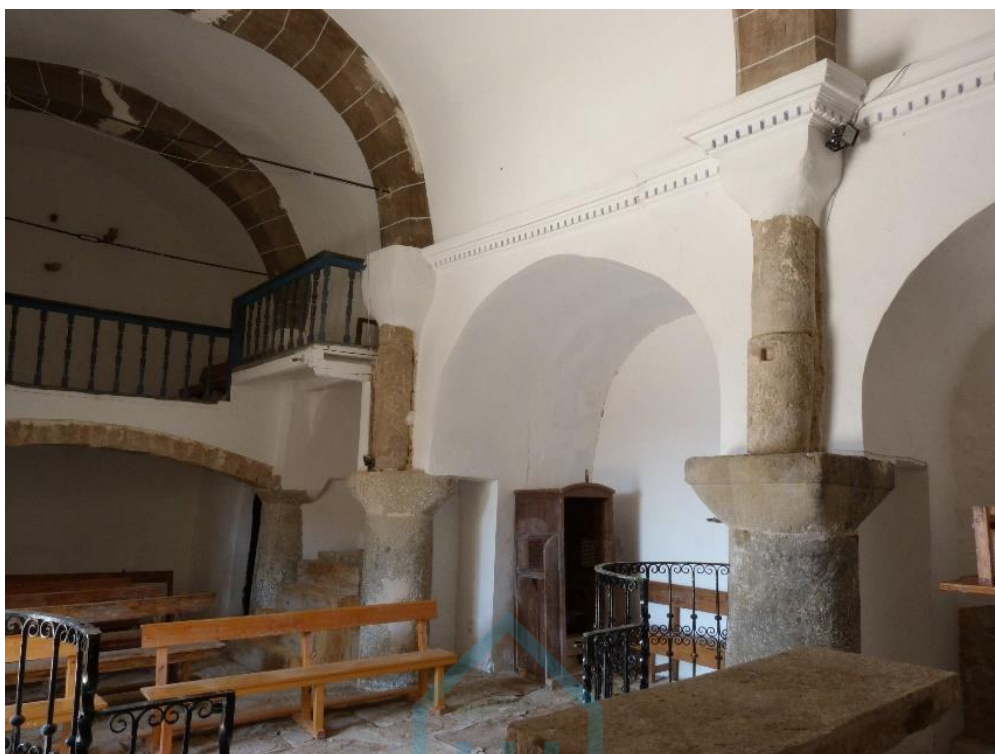
Interior de muro norte
