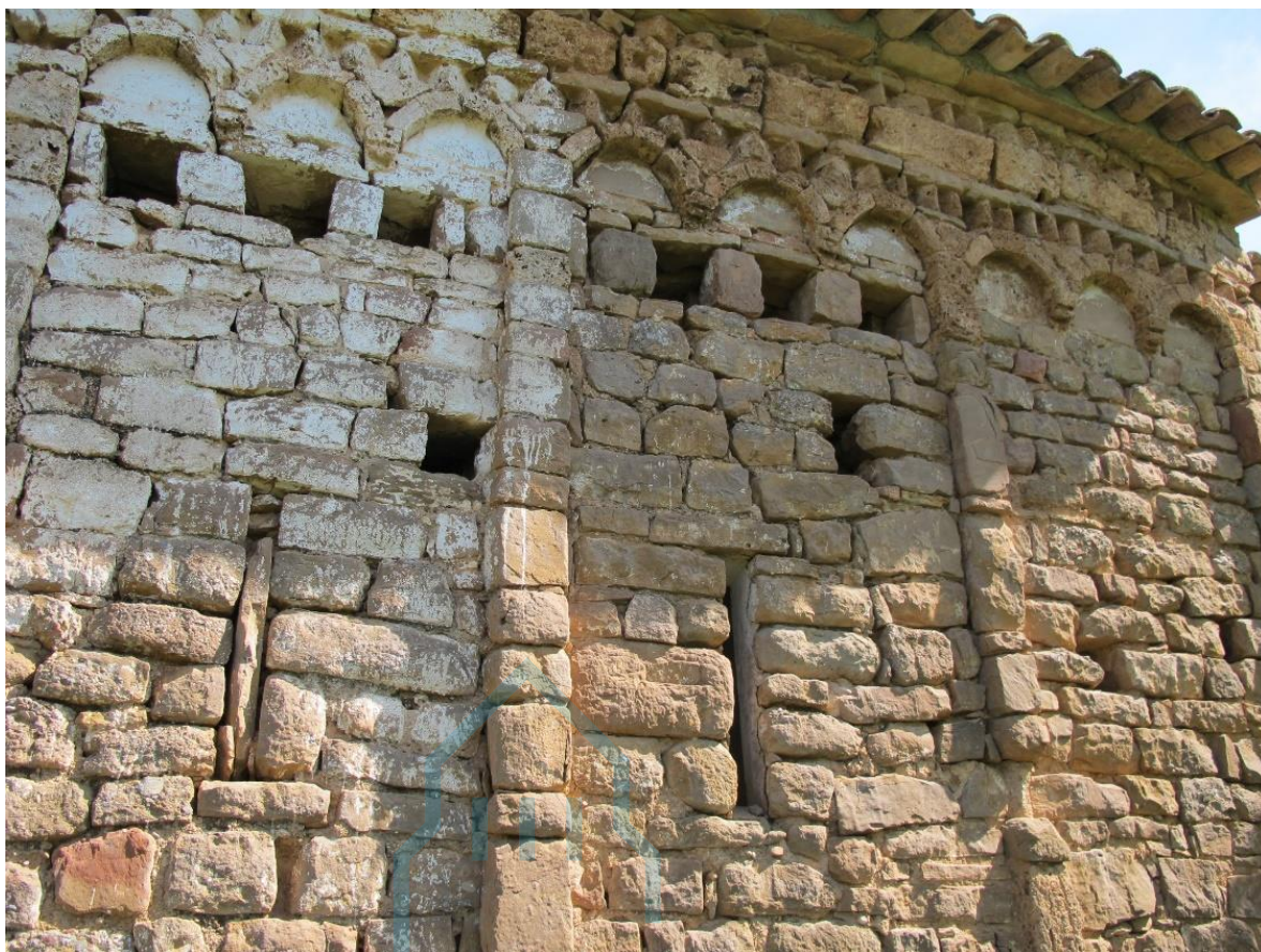
Detalle del muro sur
