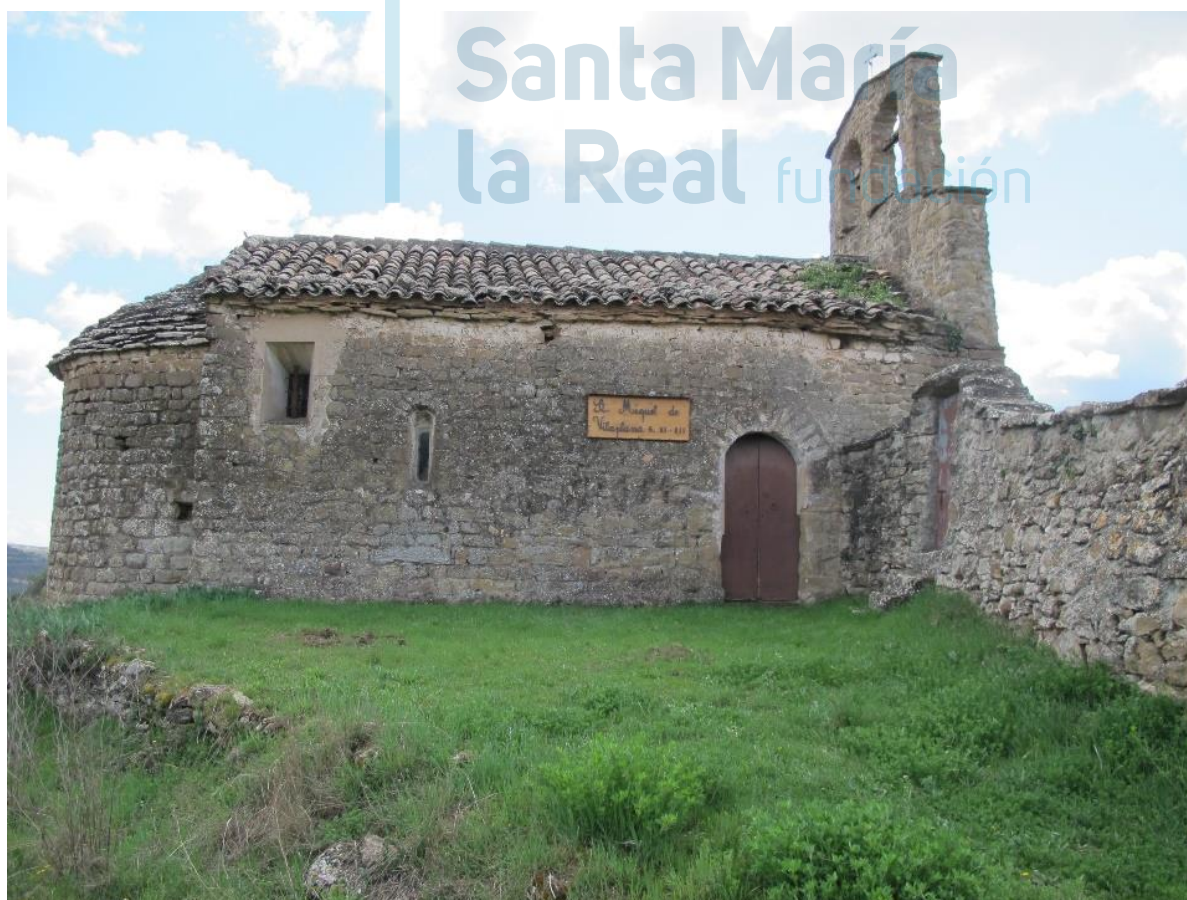
Vista general desde el norte
