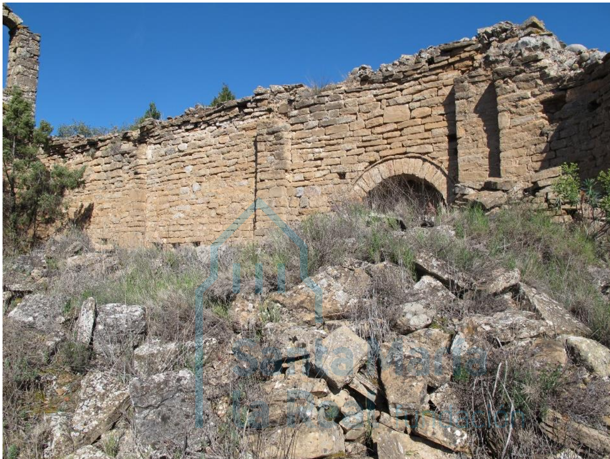
Interior del muro norte
