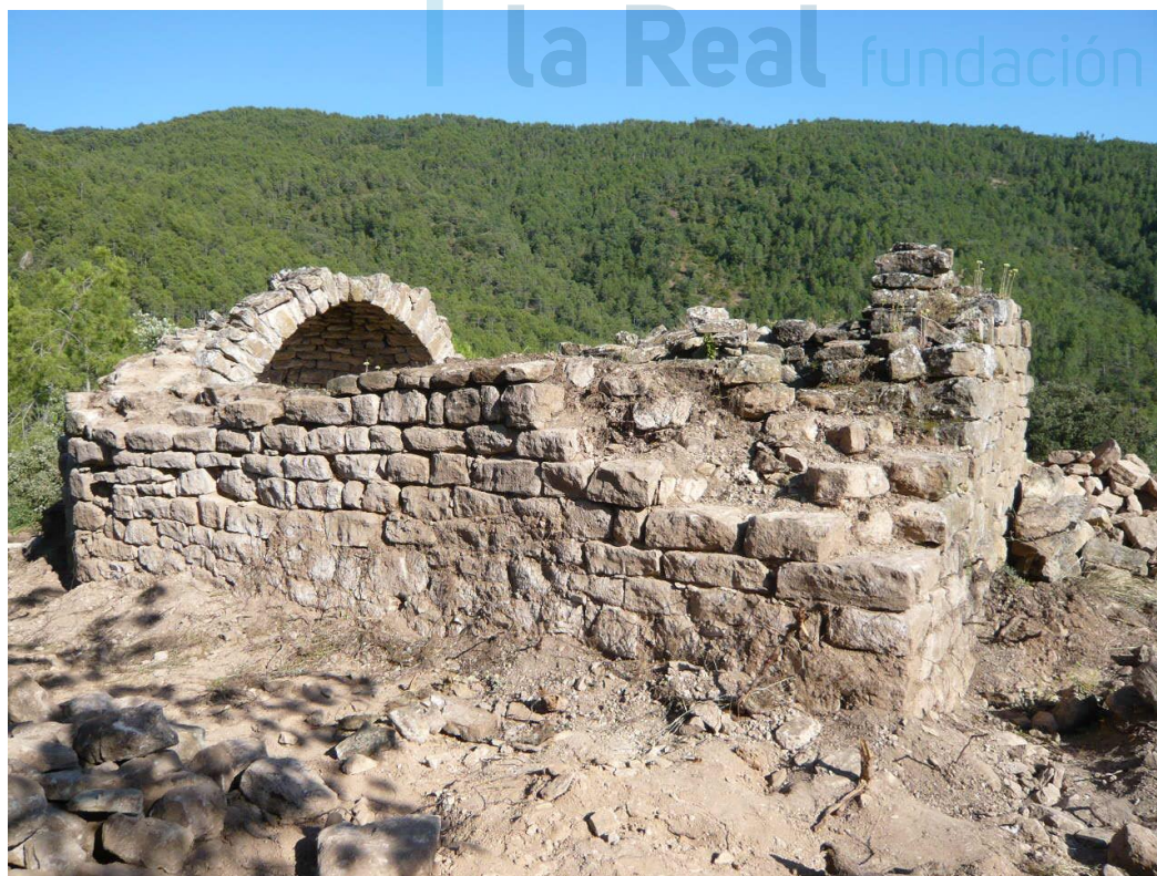
Vista general antes de la restauración
