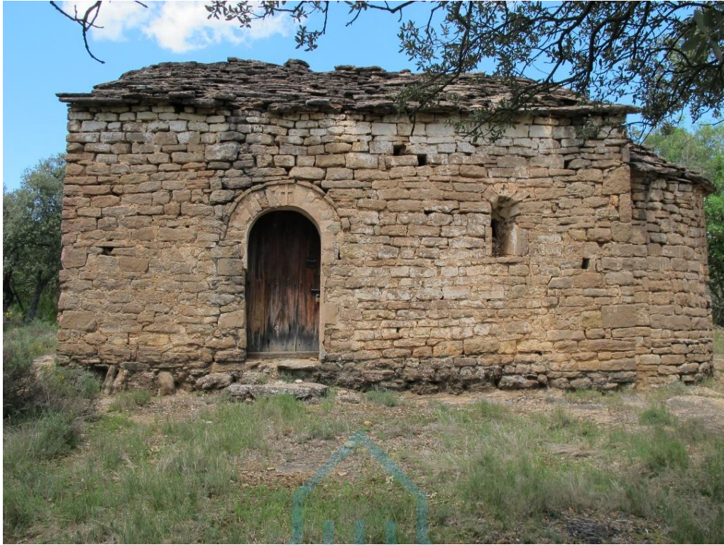
Vista del exterior desde el sur
