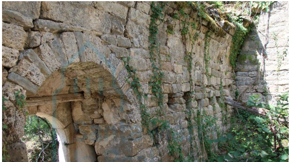
Detalle del arranque de la bóveda
