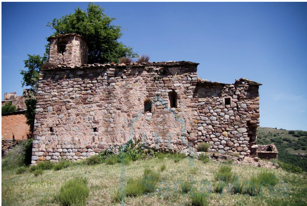
Vista exterior desde el sur
