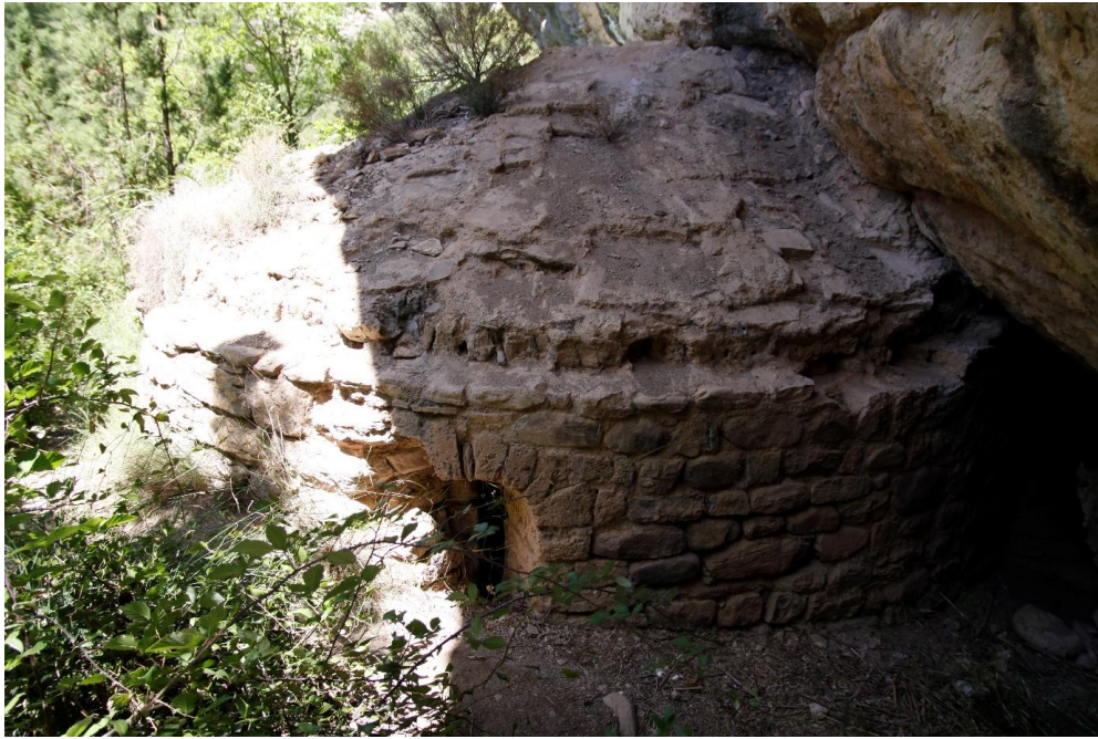
Exterior del ábside principal
