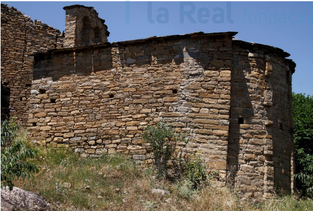
Vista exterior desde el sur
