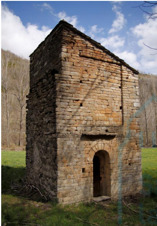
Vista exterior desde el noroeste
