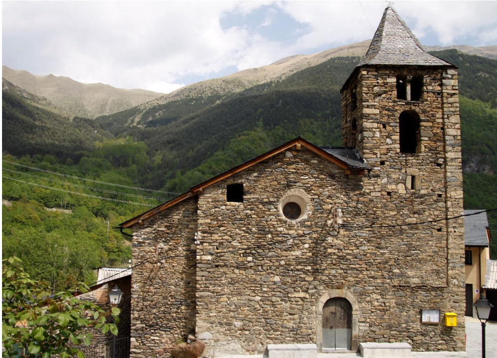
Fachada oeste y campanario
