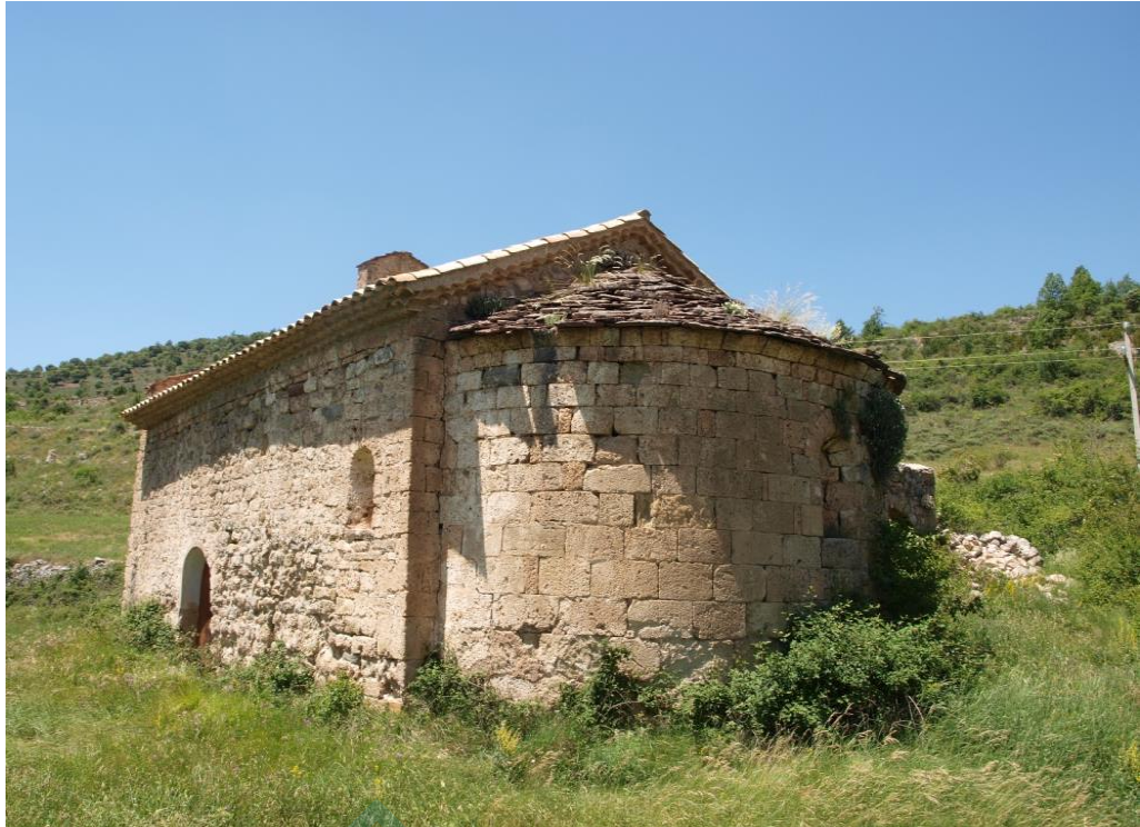
Ábside y muro sur
