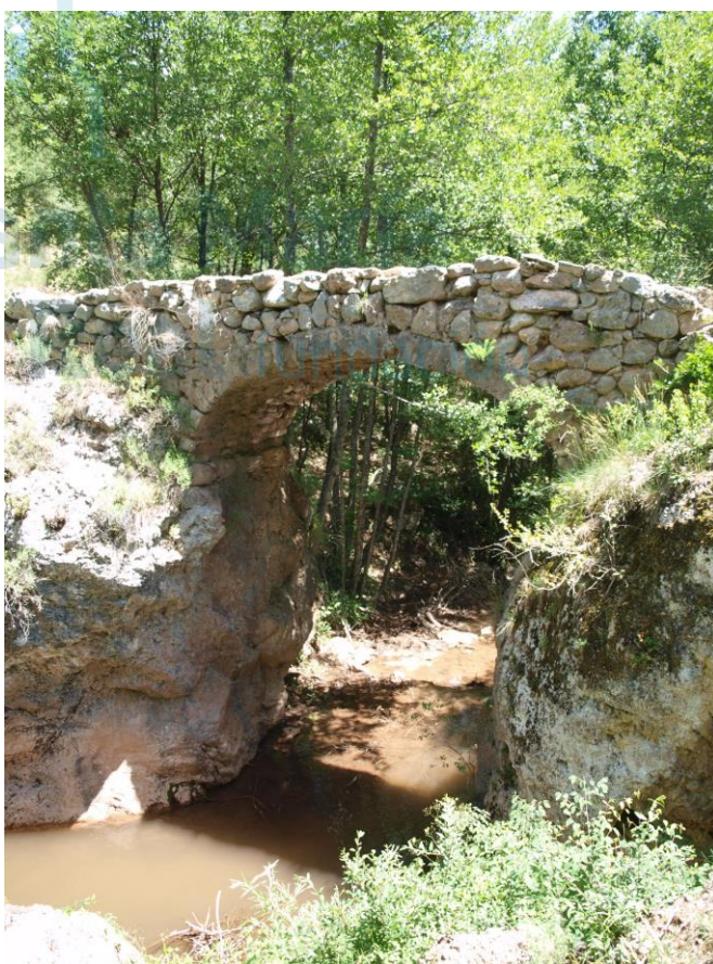
Vista del puente
