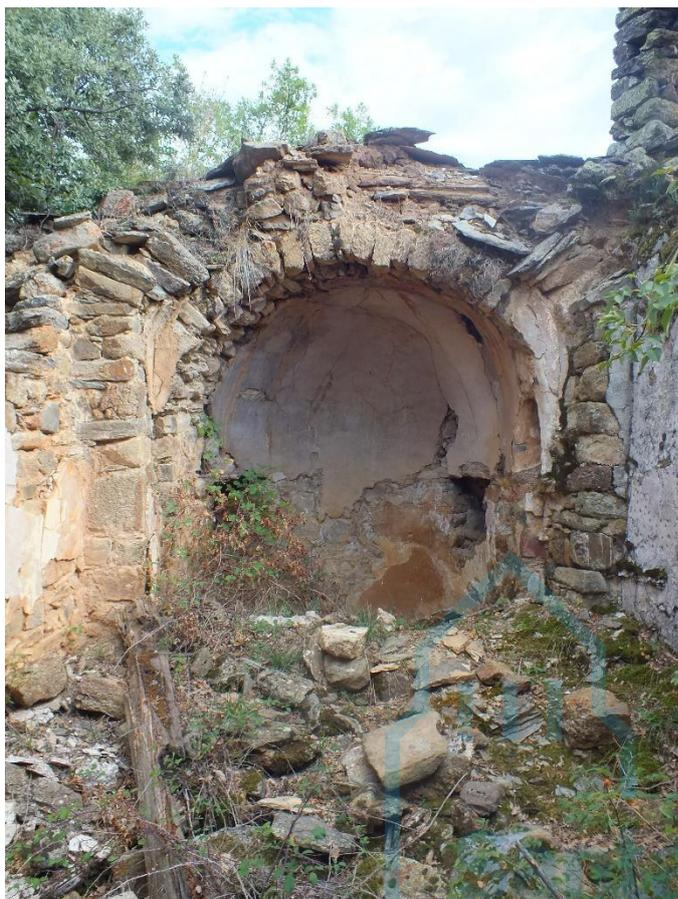
En lo alto, una hilada de finas losas parece marcar lo que pudo ser la altura original de este lienzo. Las hiladas colocadas sobre ella parecen ser fruto de un sobrealzado del muro. El resto de muros perimetrales son lisos y carecen de vanos, salvo el meridional, en cuyo tramo occidental se halla la puerta. El campanario de espadaña, de un solo ojo, se alza adosado al muro sur de forma paralela al eje longitudinal de la nave.
