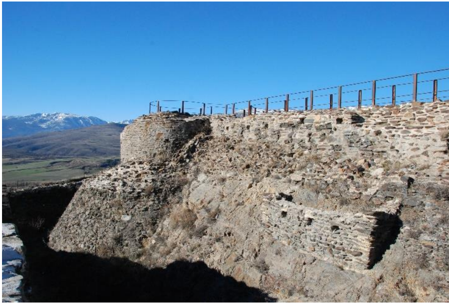
Torre circular y base de torre cuadrada
