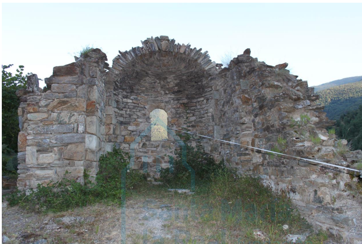
Vista de los restos del ábside
