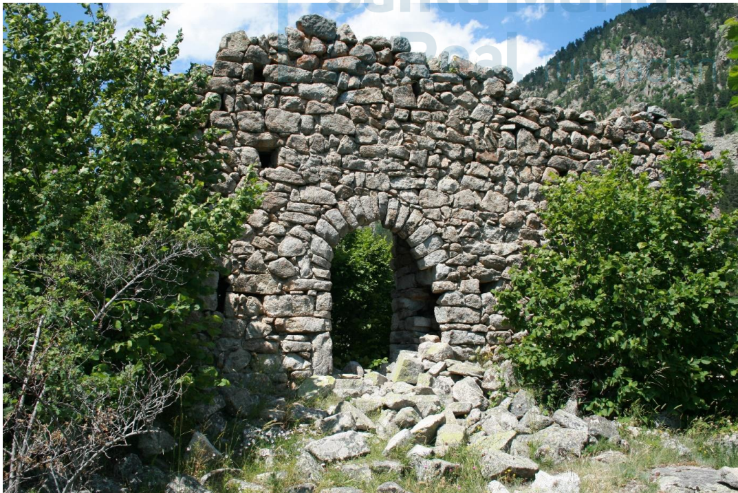
Restos de la muralla y portada del castillo
