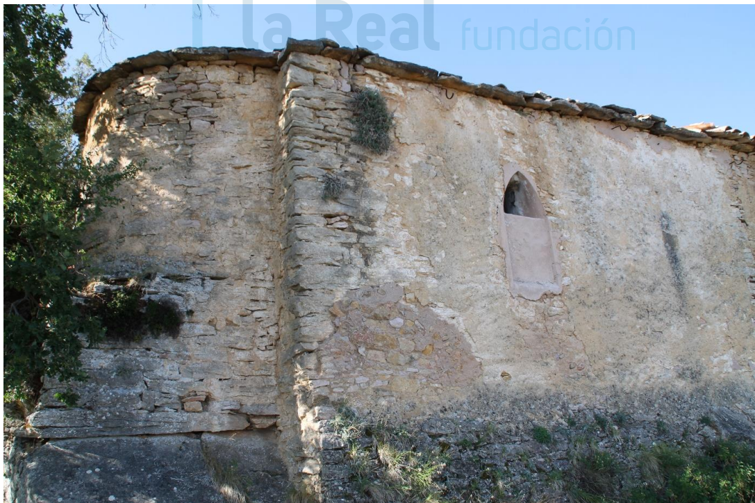
Vista exterior del ábside y del muro norte
