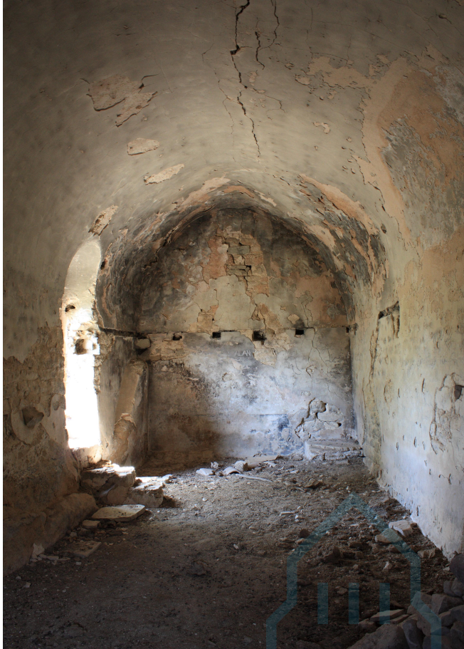
Interior hacia el oeste
