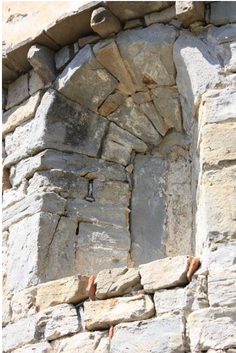
Detalle de la ventana del ábside
