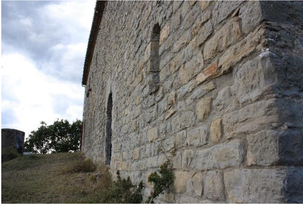
Paño de muro románico
