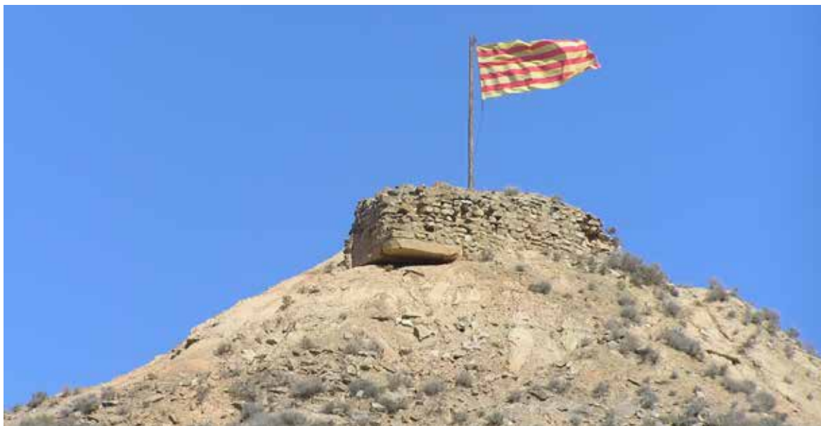
Vista general de los restos de la torre
