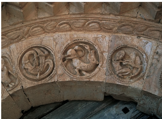
Detalle del arco de ingreso
