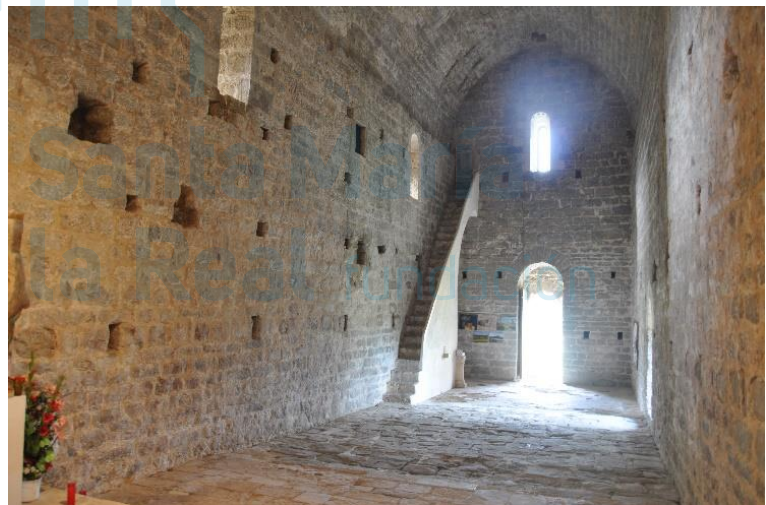
Interior. Vista hacia el oeste
