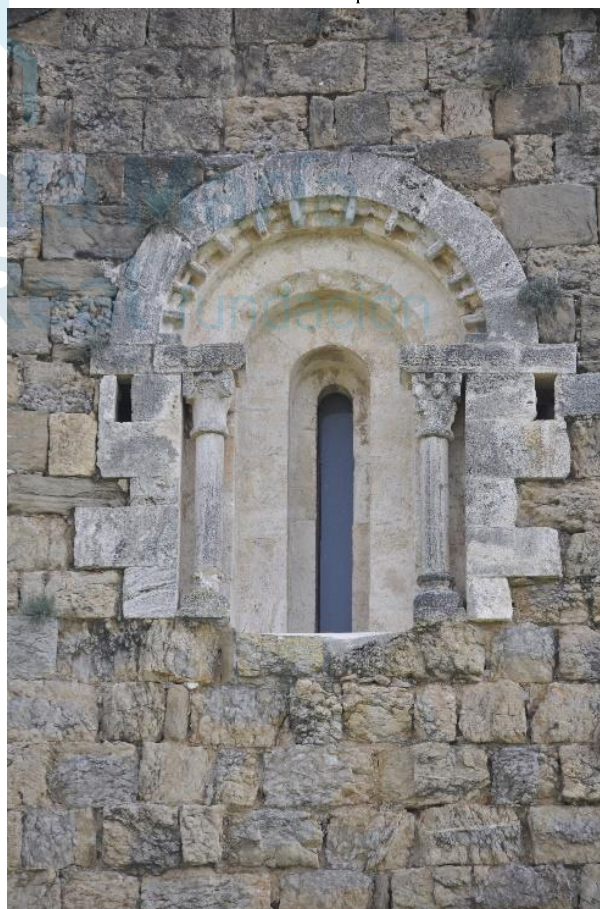
Detalle de ventana en la fachada oeste
