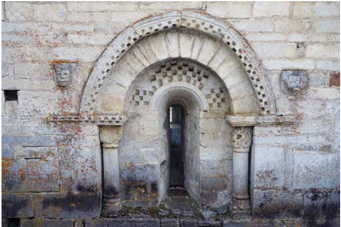
Detalle de una de las ventanas de la fachada septentrional
