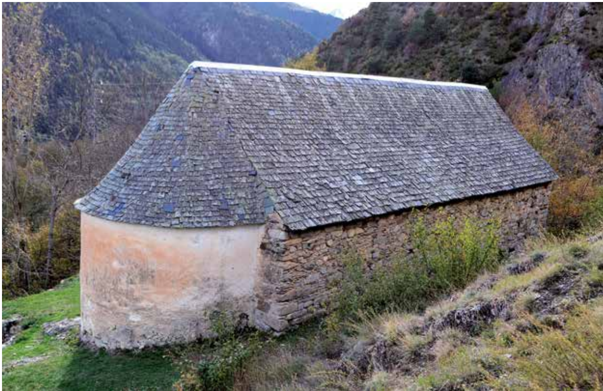
Ábside y muro norte
