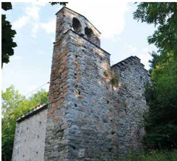
Fachada norte y campanario
