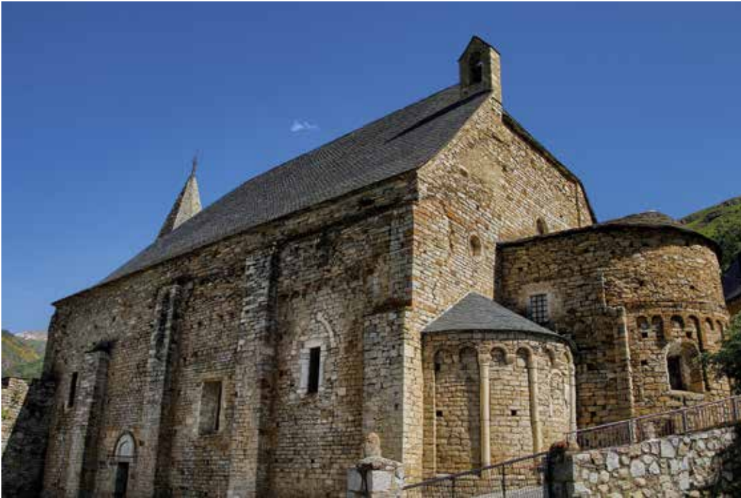
Vista general desde el Sureste
