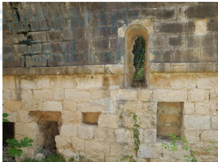
Ventana en el muro sur de la capilla (interior)
