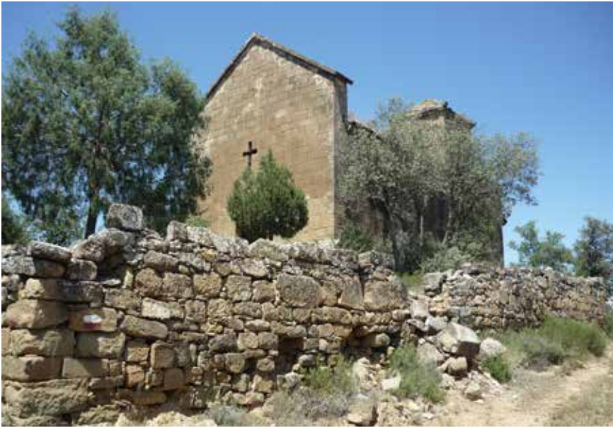
Vista general desde el Suroeste
