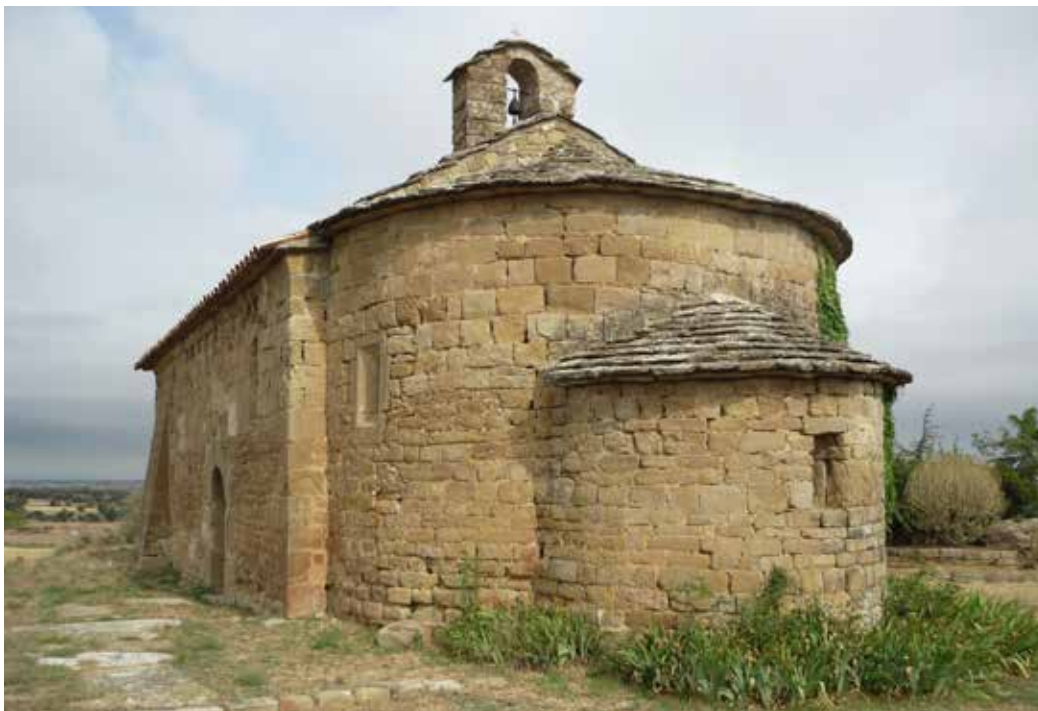
Vista exterior de la cabecera
