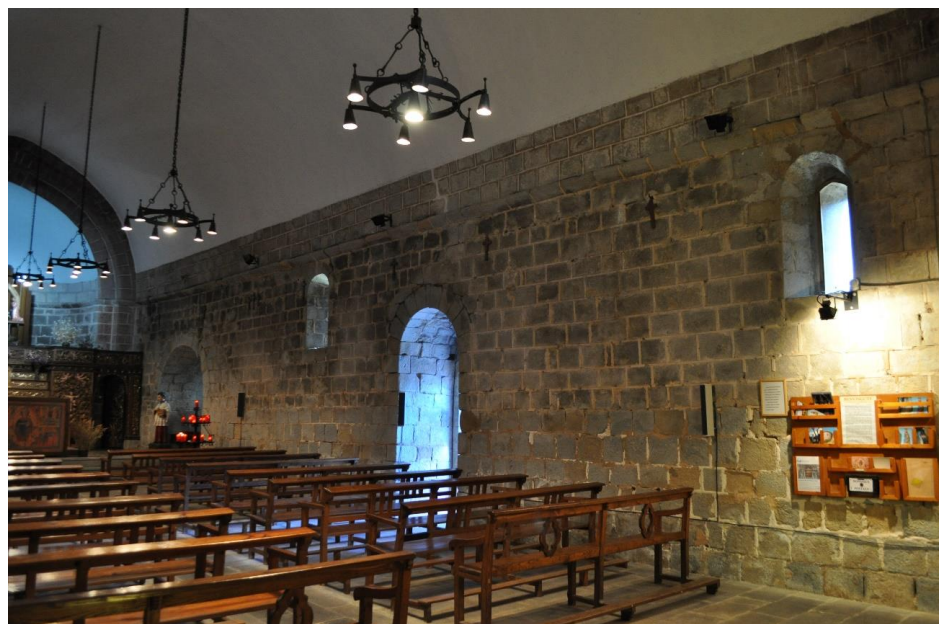
Interior. Detalle del muro sur
