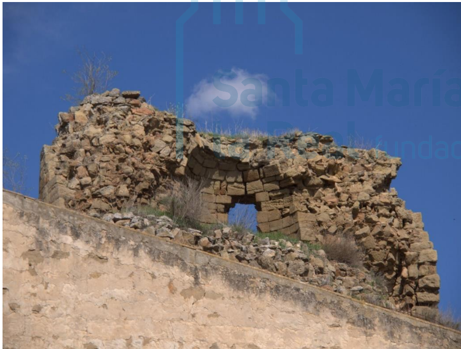
Vista interior de los restos de la torre
