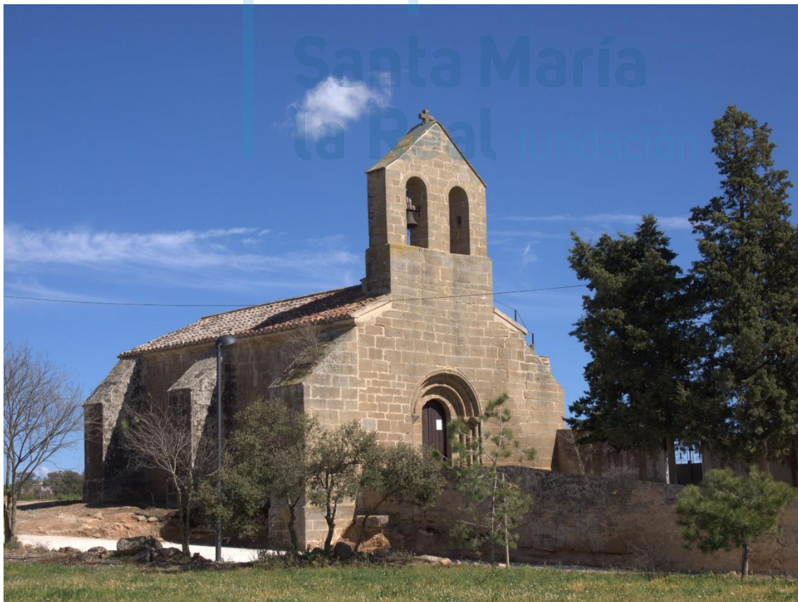
Fachada oeste y muro norte
