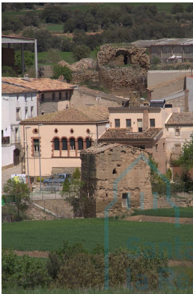
Vista general del molino y de la torre del castillo (al fondo)
