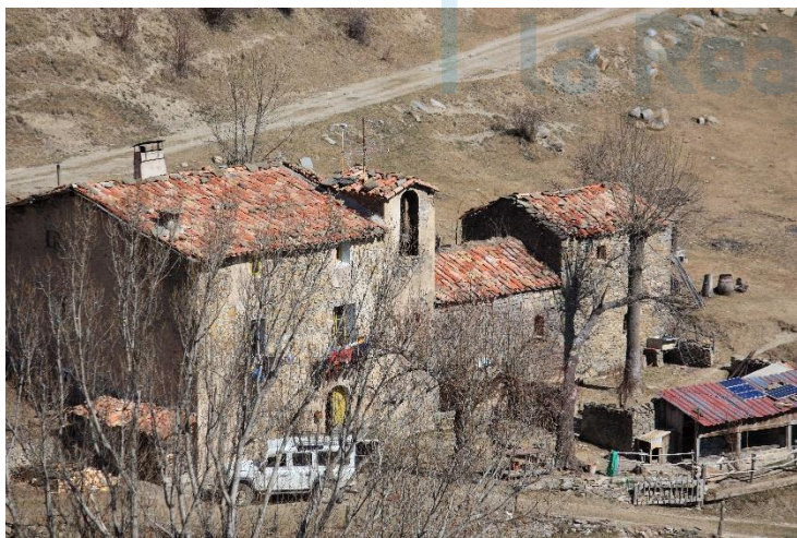
Vista general del conjunto
