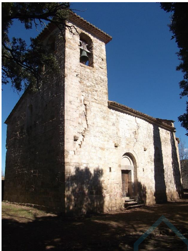
Vista general desde el suroeste
