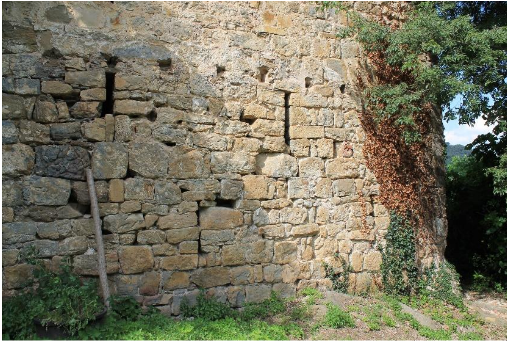
Detalle del muro meridional con aspilleras
