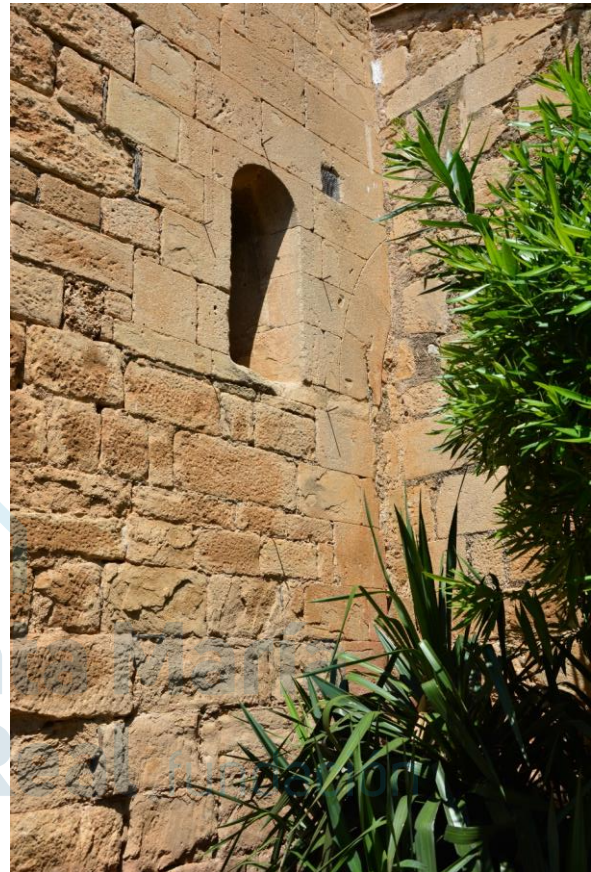
Ventana en fachada sur
