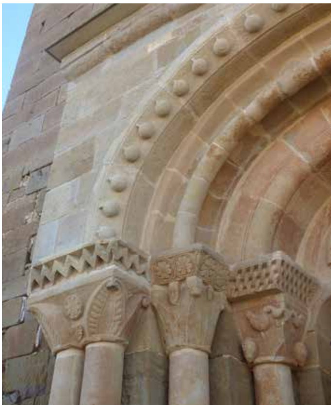
Capiteles del lado norte de la portada y detalle de las arquivoltas
