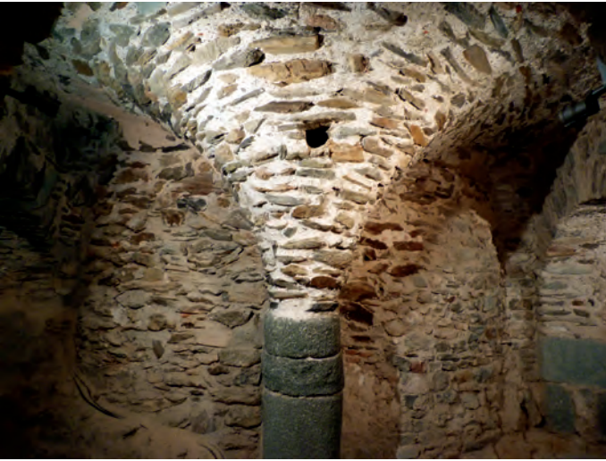
Cripta: pilar adosado al muro occidental, que probablemente pertenece a una iglesia anterior
