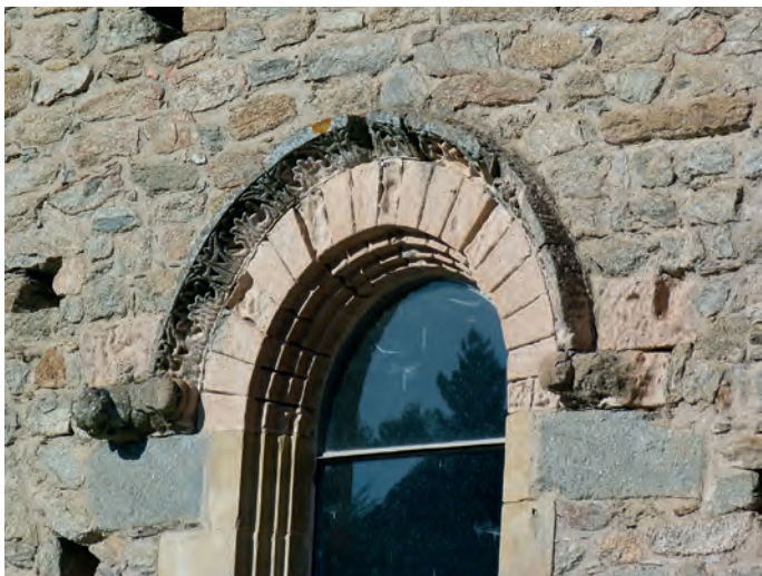
Ventana de la fachada occidental de la iglesia
