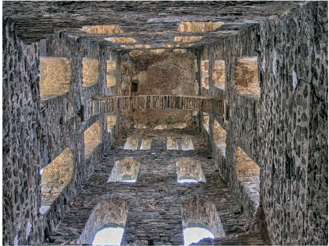
Interior de la torre campanario
