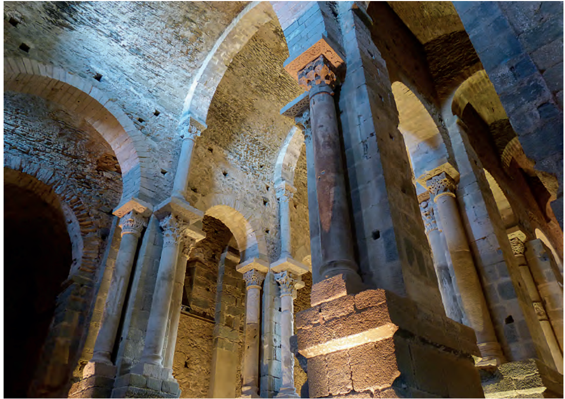
Pilares de separación de las naves
